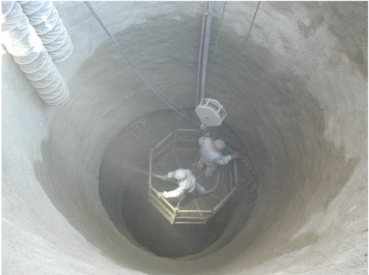
Abbildung 4 Arbeiter beim Spritzbetonverbau
