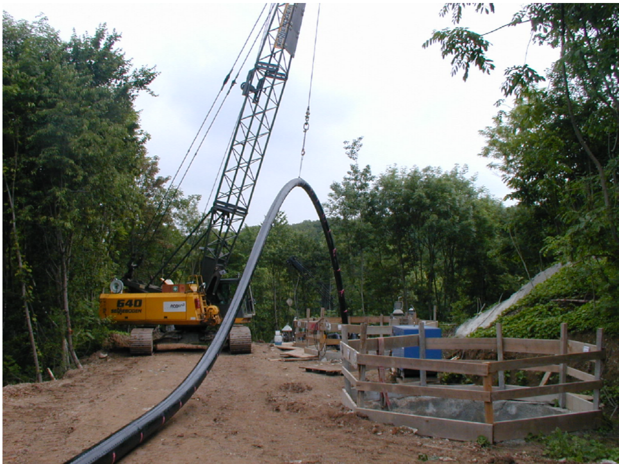
Abbildung 1 Einziehen der neuen PE-HD-Rohrleitung in die Haltung FE 1
